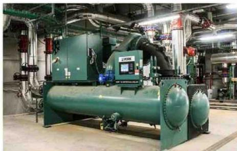
L'acqua refrigerata è prodotta da chiller con compressore centrifugo a levitazione magnetica, condensati ad acqua, che alimentano il collettore del circuito secondario
