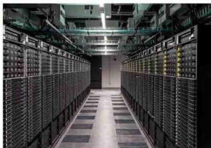
Il sistema di raffreddamento di Leonardo è del tipo Direct Liquid Cooling: utilizza acqua temperata a 36 °C prodotta mediante dry cooler adiabatici (CINECA)
