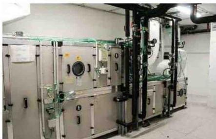
Tutte le principali attività del data center necessitano di un minimo ricambio igienico dell'aria (0,5 vol/h) con controllo dell'umidità dell'aria negli ambienti
