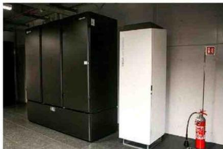
I locali IT, trasformatori/UPS, blindosbarre e batterie sono climatizzati da Computer Room Air Handler di diverse potenze, del tipo under o a dislocamento
