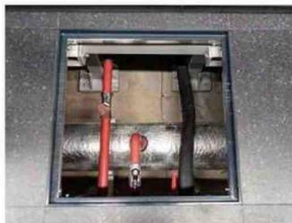
Tutte le reti di distribuzione e i terminali sono controllati da un impianto di rilevazione delle perdite, con sensoristica puntiforme e continua a nastro (CINECA)
